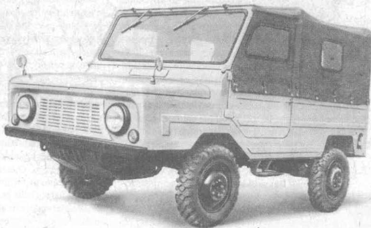
Фото 13. Автомобиль-транспортёр ЛуАЗ-967М серийного производства первых выпусков. На бортах машины закреплены съёмные трапы.
